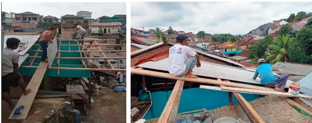
Gambar 4. Pemasangan atap: pemasangan asbes
